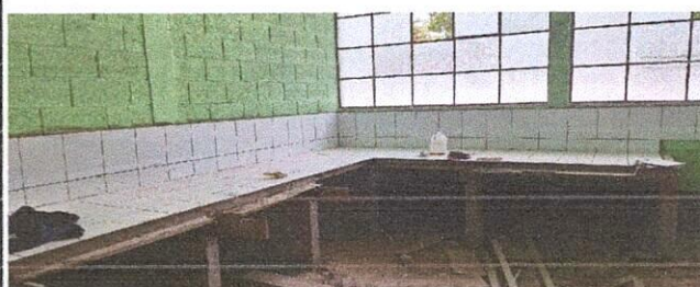
Foto 2: SUSTITUCIÓN Y REPARACIÓN DE AREA DE COCINA
